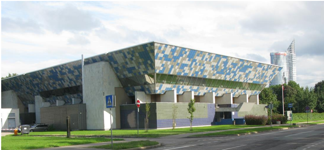
15.attēls. Padomju laika būvperioda apbūve – Ķīpsalas peldbaseins
