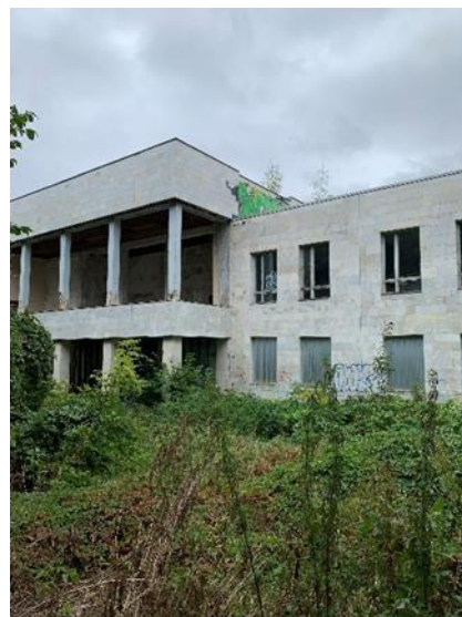
Attēls 19 Viesnīcas fasāde.
