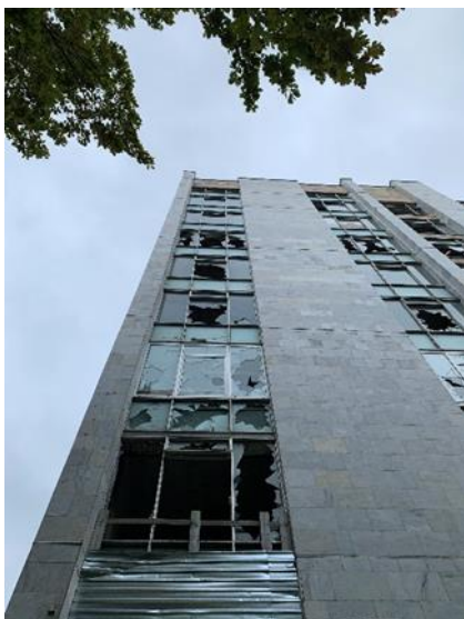
Attēls 17 Viesnīcas fasāde.
