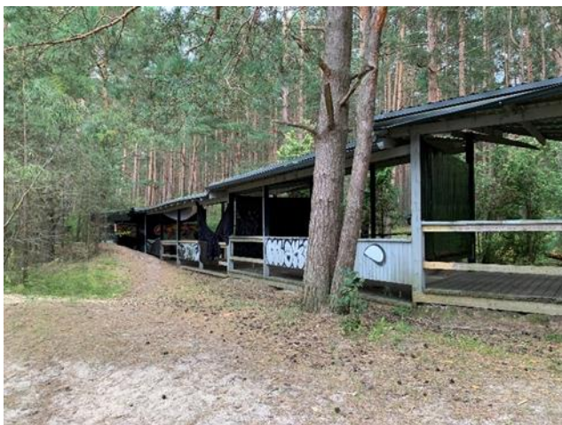
Attēls 22 Būve kāpu zonā.
