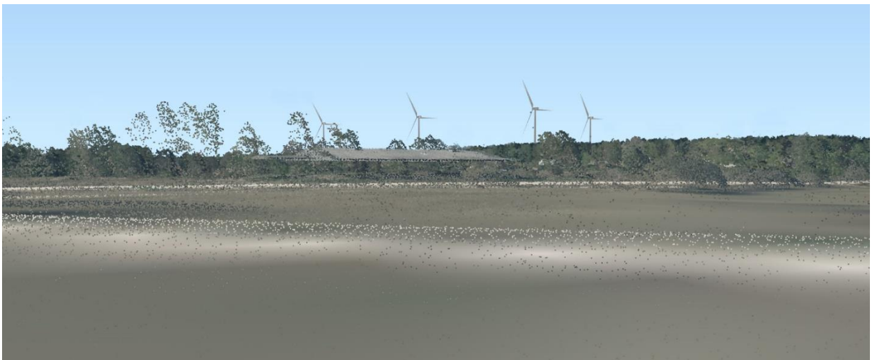
19.attēls. Skats Nr.20 detālpārplānojuma teritorijas virzienā no autoceļa V1316 uz Vēdi. Avots: SIA METRUM 3D modelis
