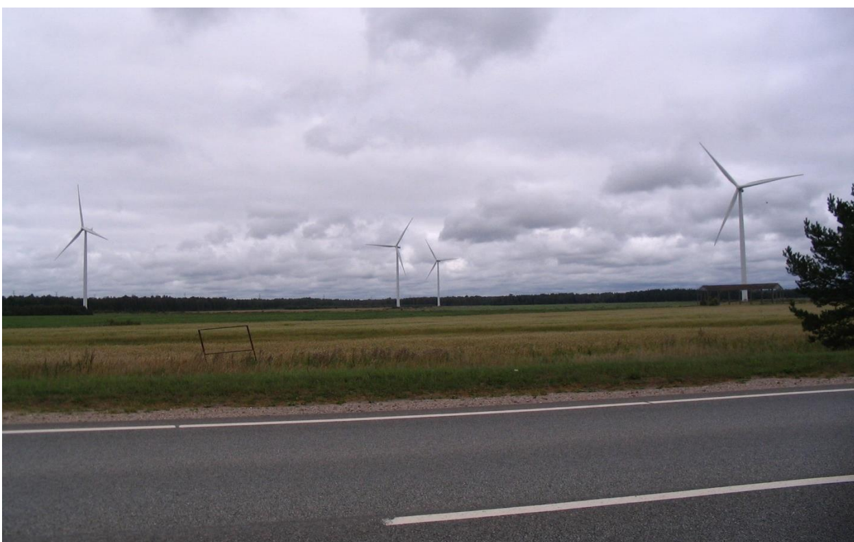
12.attēls. Skats uz Platenes elektrostaciju no valsts autoceļa E22. Foto: M. Blūma
